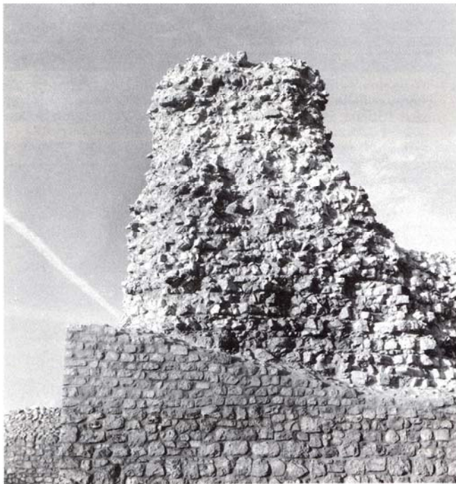
8.10 Gesichertes Kernmauerwerk — siehe dazu Abb. 6 — der ehemalige Turm wurde durch neues Mauerwerk auf der nachgewiesenen Flucht wieder ablesbar gemacht. (Objekt: Veringensstadt, Kreis Sigmaringen, Region Bodensee — Oberschwaben.)
