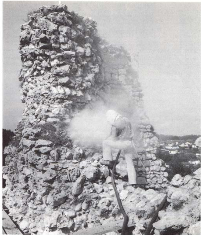
8.6 Reinigen des Bestandes durch Sandstrahlen nach vorangegangener Entfernung von Bewuchs und Humus. (Objekt: Veringenstadt, Kreis Sigmaringen, Region Bodensee — Oberschwaben.)
