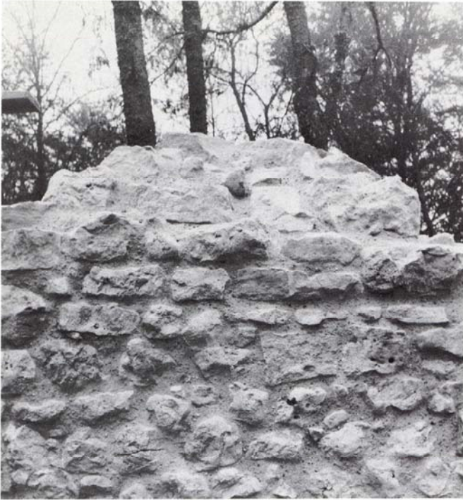
8.9 Beispiel für einen etwa bündigen Fugenschluß auf grobem Mauerwerk. Die obersten zwei Schichten der Außenschale und die Übermauerung der Krone wurden ergänzt durch neues Mauerwerk. (Objekt: Hohenstein, Kreis Reutlingen, Region Neckar — Alb.)
