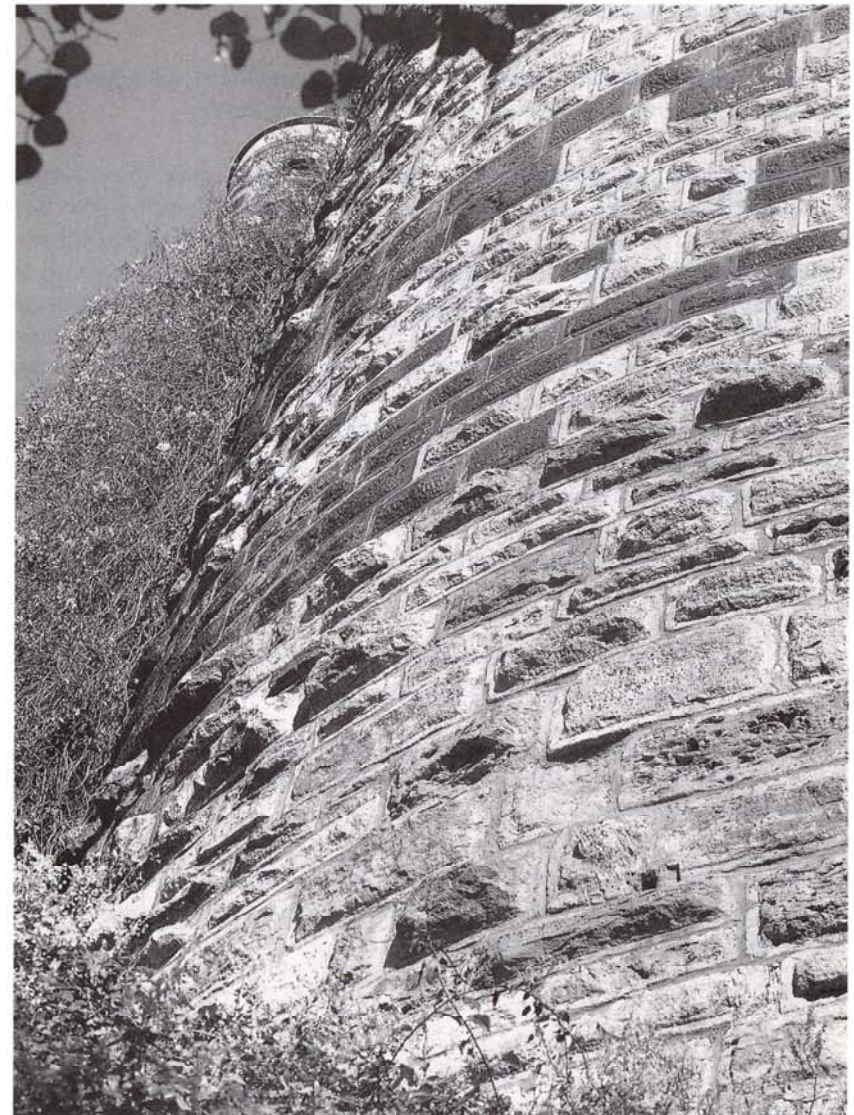
Abb. 10: BESIGHEIM (wie Abb. 11), Detailaufnahme mit erkennbarer Formgrenze zwischen Buckeltyp III und IV sowie Materialwechsel.
