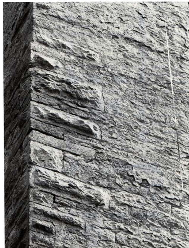
Abb. 18. Eckbuckelquader neben anschließendem hammerrechten Mauerwerk mit Resten alten Verputzes, etwa auf halber Höhe des Turmschaftes (Foto: Preiser)
