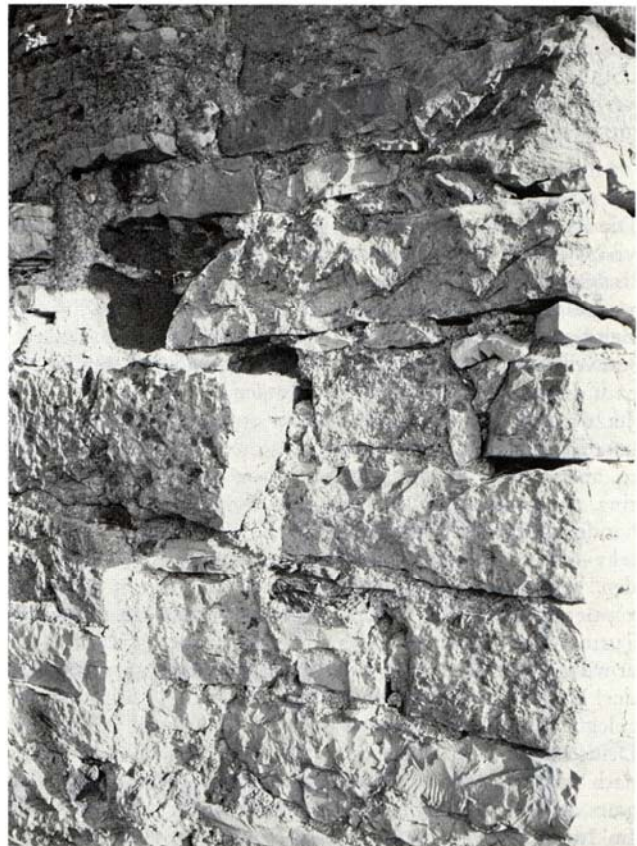
Abb. 20. Mauerwerksbefund an der Westecke, Höhe etwa 295 m ü. N.N.; siehe auch Ansicht Abb. 4. Auffällig ist der Unterschied zur Ecke auf Abb. 18 (Foto: Pfefferkorn)
